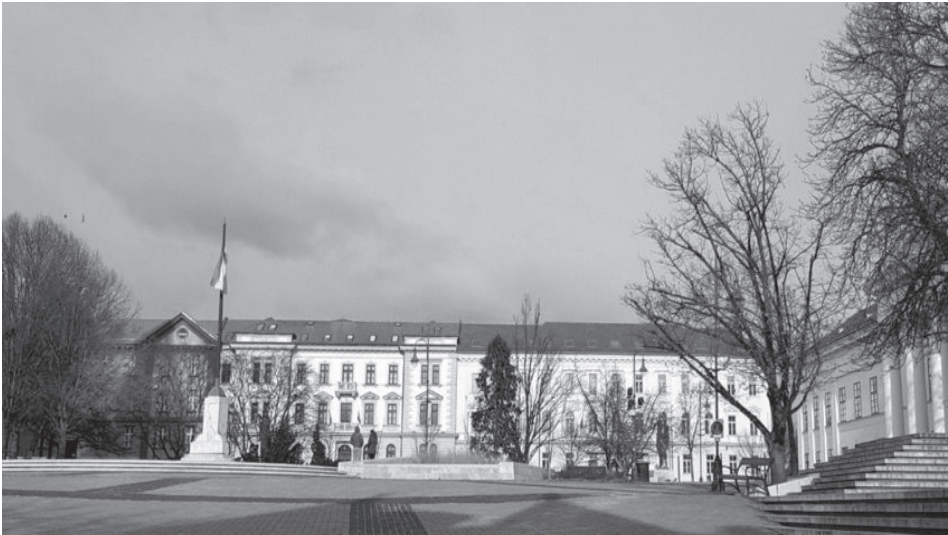
3. kép: A felújított törvényszéki és börtönépület Szekszárdon.*
